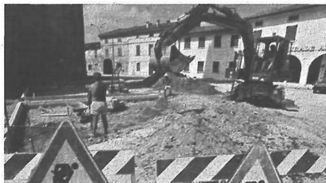
Una fase dei lavori nella piazza di Pescarolo
