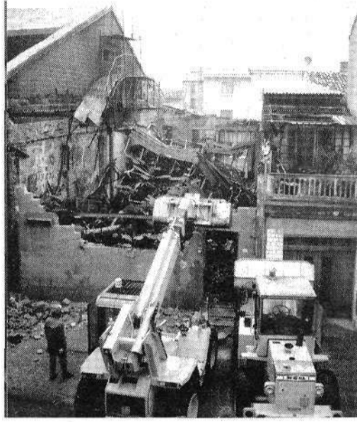
Si procede alla demolizione della facciata
